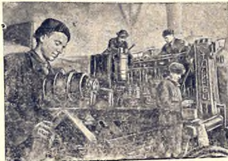
Бригада механика т. Карженевского за ремонтом.
