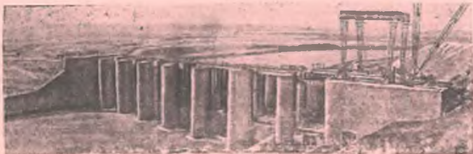
На снимке: общий вид плотины Фархадской ГЭС
