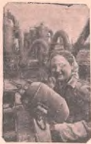
На восстановленном Таганрогском металлургическом заводе имени Андреева. На снимке: подготовка готовых труб к отправке на бакинские нефтепромыслы.
