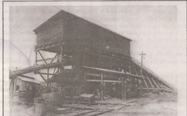
Кирпичный завод может давать за сезон больше миллиона штук кирпича, а даёт 700-800 тысяч. В план уложиться не позволяют условия труда. Сушильный сарай из-за плохой кровли протекает. Кирпич-сырец от этого портится. Узкоколейный путь износился на 80% и требует замены. Об этом в "Прожекторе" писал Ф. Вярво.
